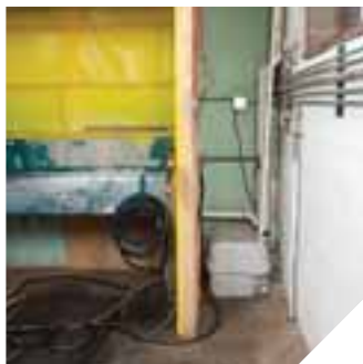
Монтаж насоса Sanicubic
