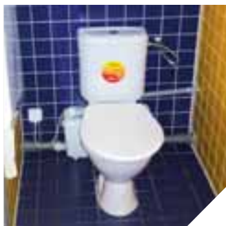
Установка Sanibest на один унитаз для взрослого
