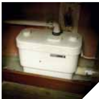
Sanispeed, вмонтированный в шкаф раковины
