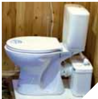
Унитаз, установленный в бане, с насосом Sanibroyeur
