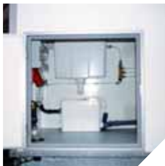
Система SFA, установленная под входными дверями
