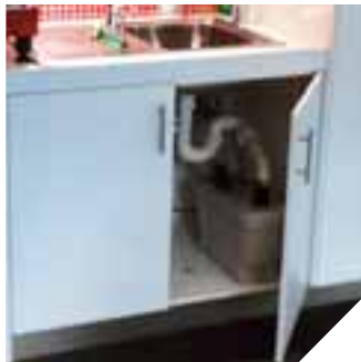
Sanispeed, вмонтированный в шкаф раковины
