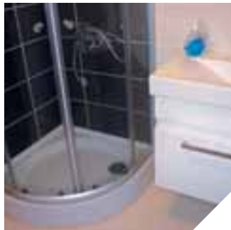
Душ, подключенный к Sanishower, скрытому за стеной
