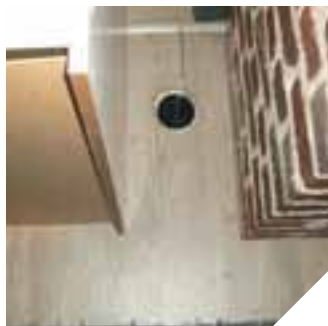
Дренажная труба, проведенная из подвала на кухню
