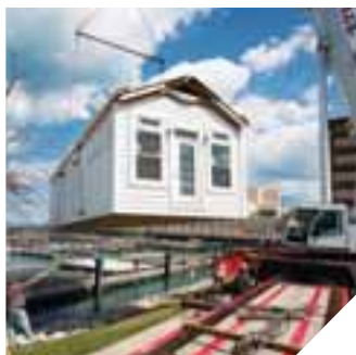
Кран устанавливает гигиеническое сооружение на воду
