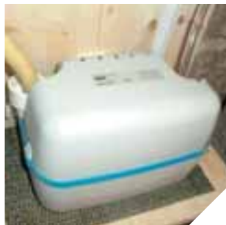
Sanicondens, соединенный с осушителем
