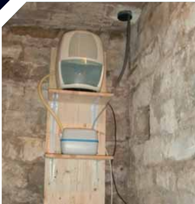
Установленный в подвале осушитель
